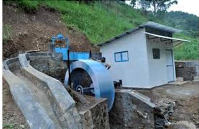
Gambar 1. 18 Aliran air sebagai penggerak kincir air
